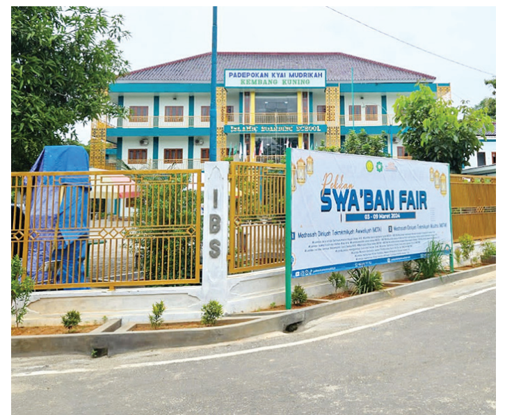
MEGAH: Bangunan gedung utama IBS PKMKK tampak dari luar.
